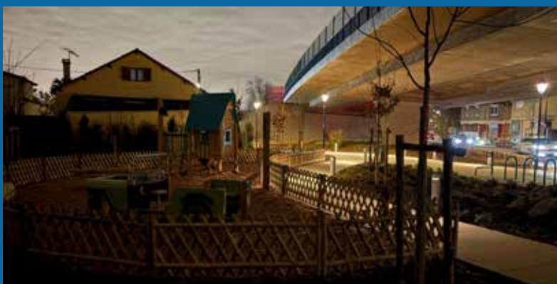
Aménagement paysager sous le pont de la RN6 et installation d'une aire de jeux pour enfants et d'un terrain de pétanque
